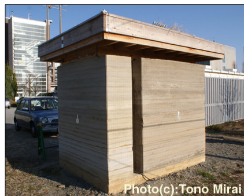
04_版築シェルター…前橋工科大における版築の実験施設 土の強度と温熱環境の測定を行なっている (群馬県・前橋市 2012年)
