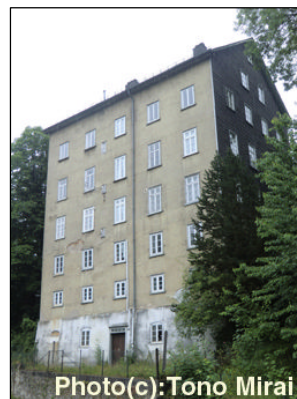
02_高層の版築…ヨーロッパ最高高さの版築の家 (ドイツ・ヴァイルブルク 1828年)
