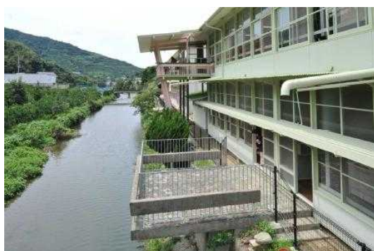
川に張り出したベランダと外部ステージ オリジナルのデザインを損なわないよう安全に配慮した手摺りが追加され修復された。
