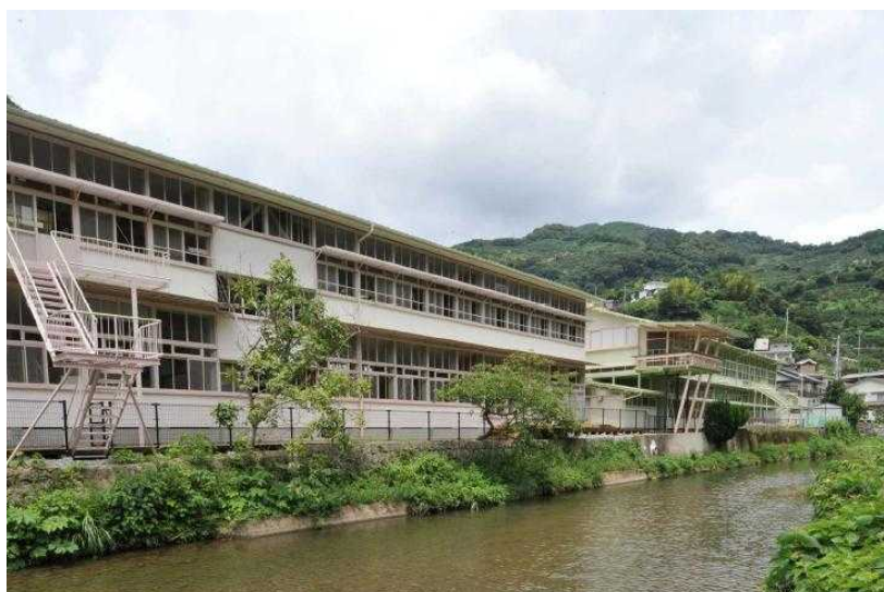
既存校舎はオリジナルを尊重して改修された。
