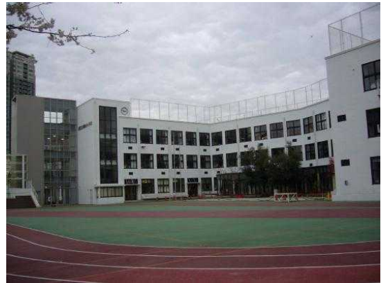
左側が増築部分。階段室サッシュはオリジナルにもどされた。
