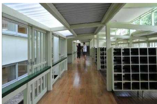
昇降口と廊下 耐震補強を行い現在の基準に合わせたが、オリジナルのデザインは活かされている。
