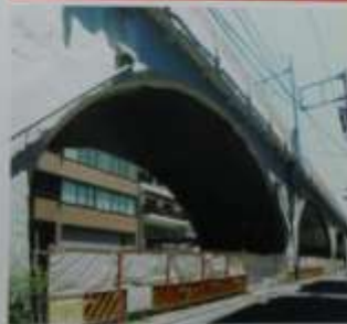
第一佐久間町高架橋
