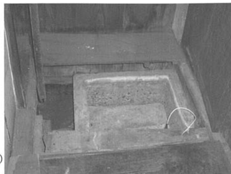
床下に残っていた溜め舂(給水槽)
